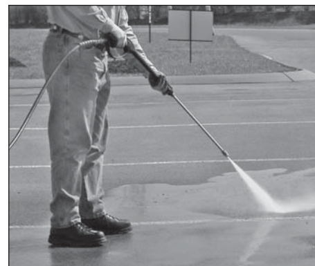
Figura 12 - Ángulo mejor para limpiar una superficie
