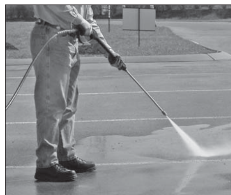
Figure 12 - Angle optimum par rapport à la surface à nettoyer
